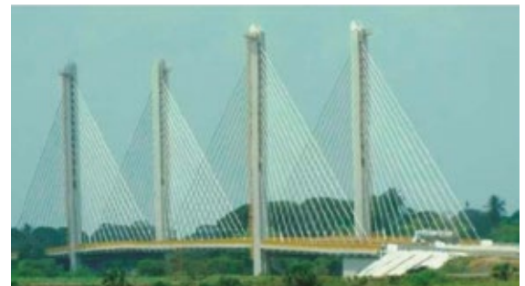
Figura 1. Puente Río Papaloapan. Fuente: IMT (2025).
